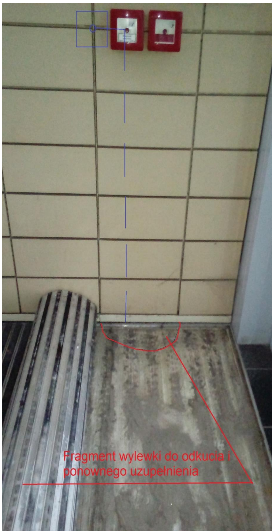
Rysunek 2. Prowadzenie przewodu i lokalizacja wyłącznika bezpieczeństwa
