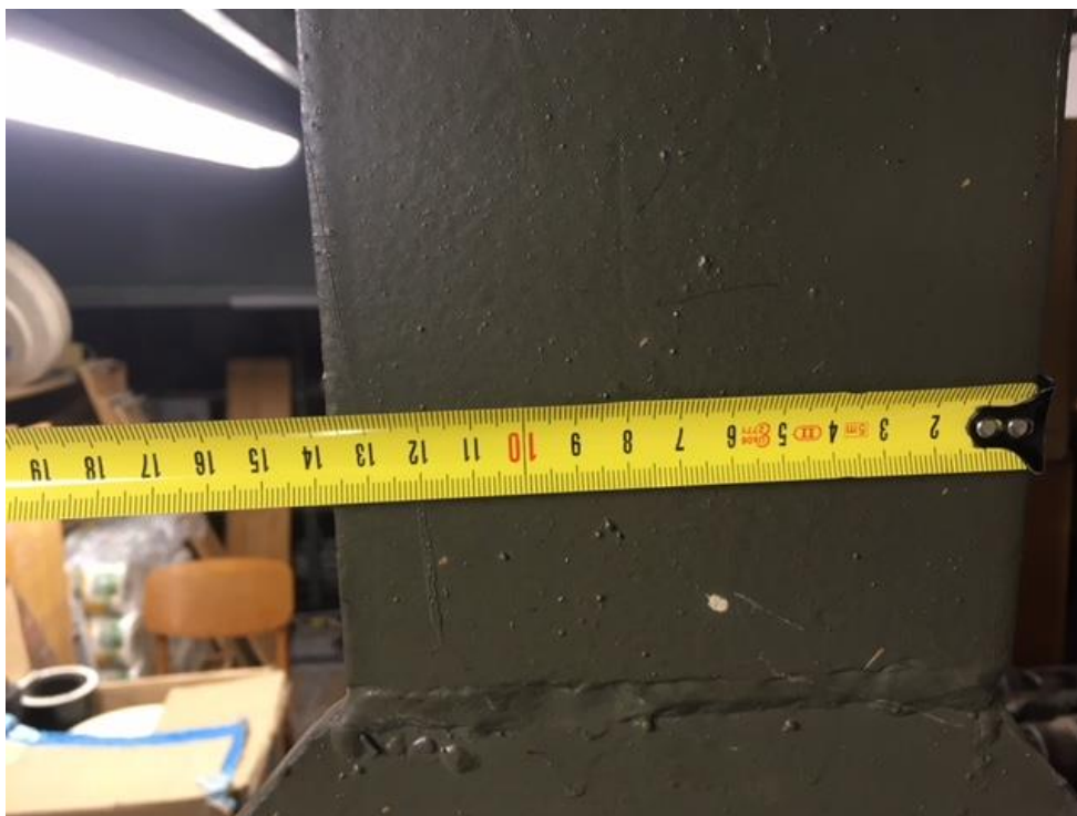
Pomiar szerokości przewiązki
