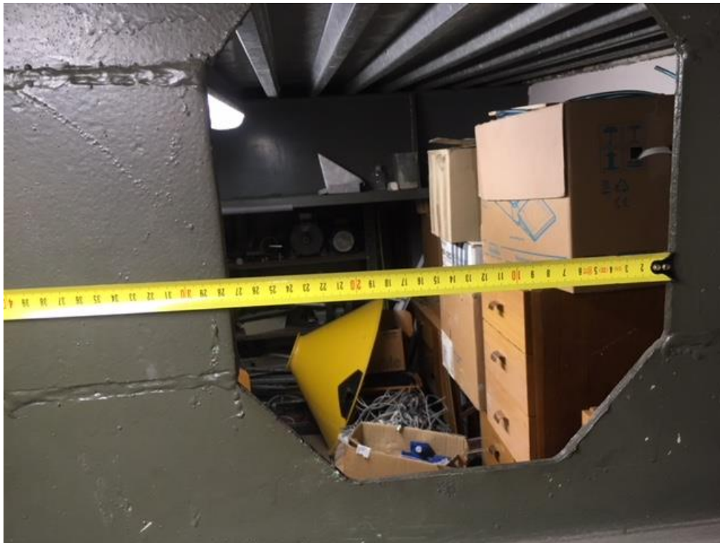
Pomiar rozstawu przewiązek
