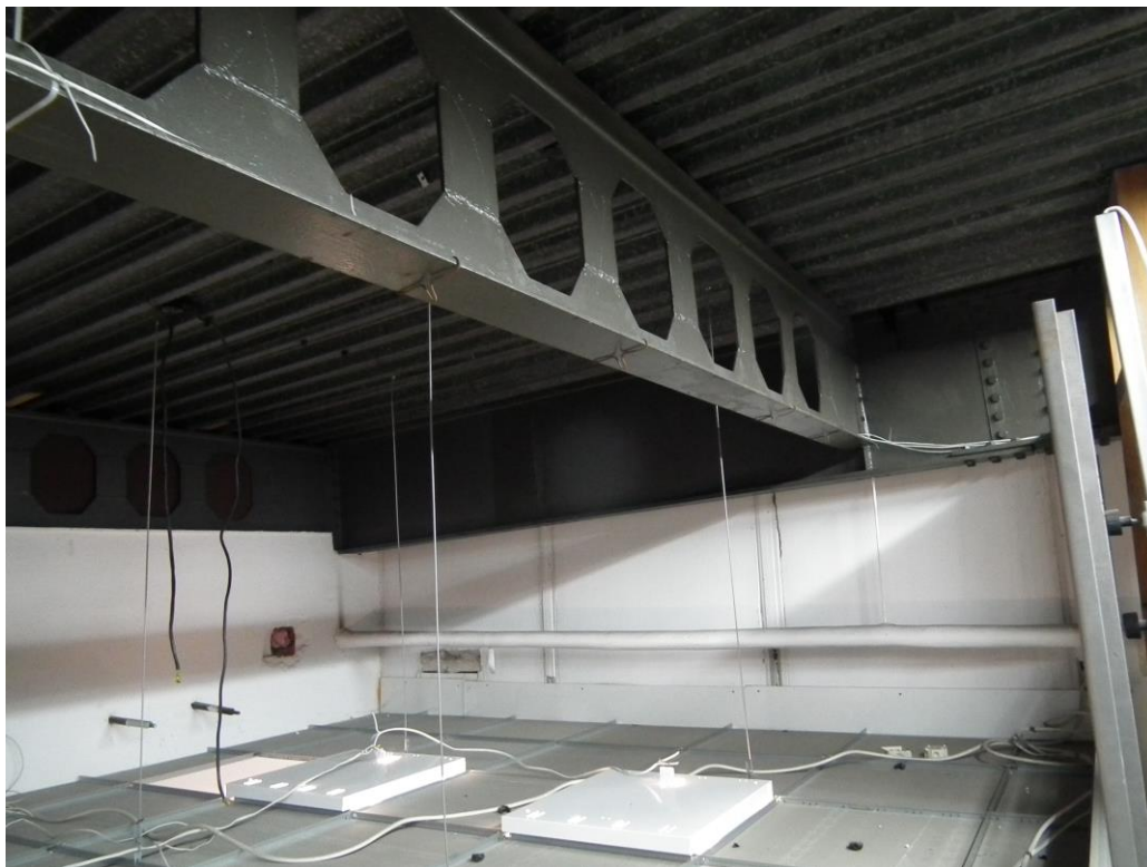
Widok płatwi ażurowej i jej połączenia z rygłem ramy głównej konstrukcji nośnej
