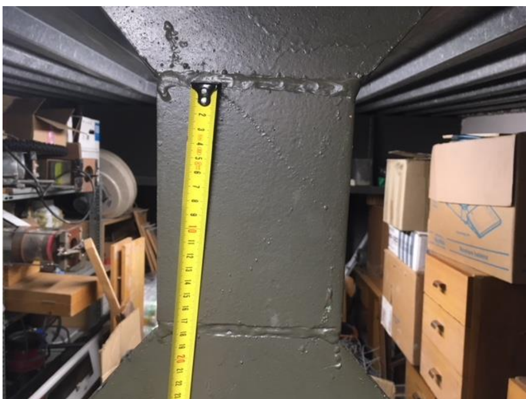
Pomiar wysokości przewiązek łączących pasy belki ażurowej
