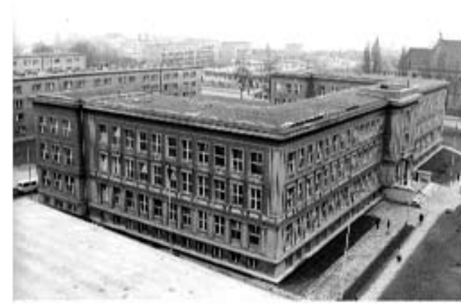
Budynek Wydziału Budownictwa Lądowego; 1974 (proj. S. Pogórski)
