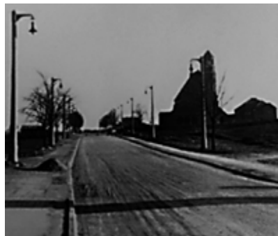
Fot. 4. Widok ul. Kórnickiej z 1950 r. (po prawej stronie kościół Św. Rocha, a po lewej tereny Politechniki)
