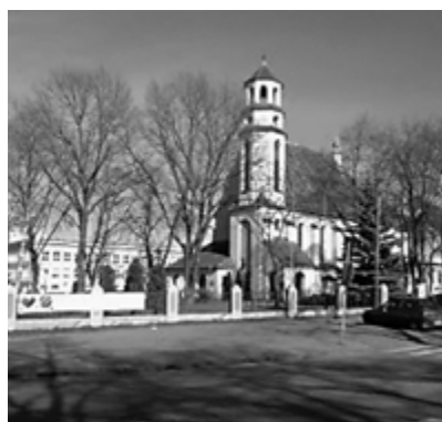
Fot. 6. ul. Kórnicka, 2018 r. (po prawej stronie kościół Św. Rocha, a po lewej - budynek Wydziału Budownictwa Lądowego)
