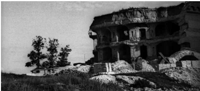
fot. 3. Rozbiórka fortu, 1947 r.
