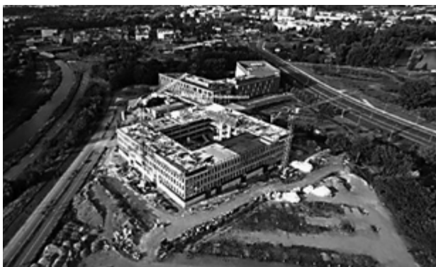
Fot. 15. W budowie budynek Wydziałów: Architektury i Inżynierii Zarządzania (2017-2019)
