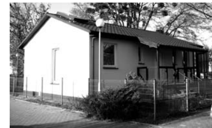
Budynek pasywny Instytutu Inżynierii Środowiska
